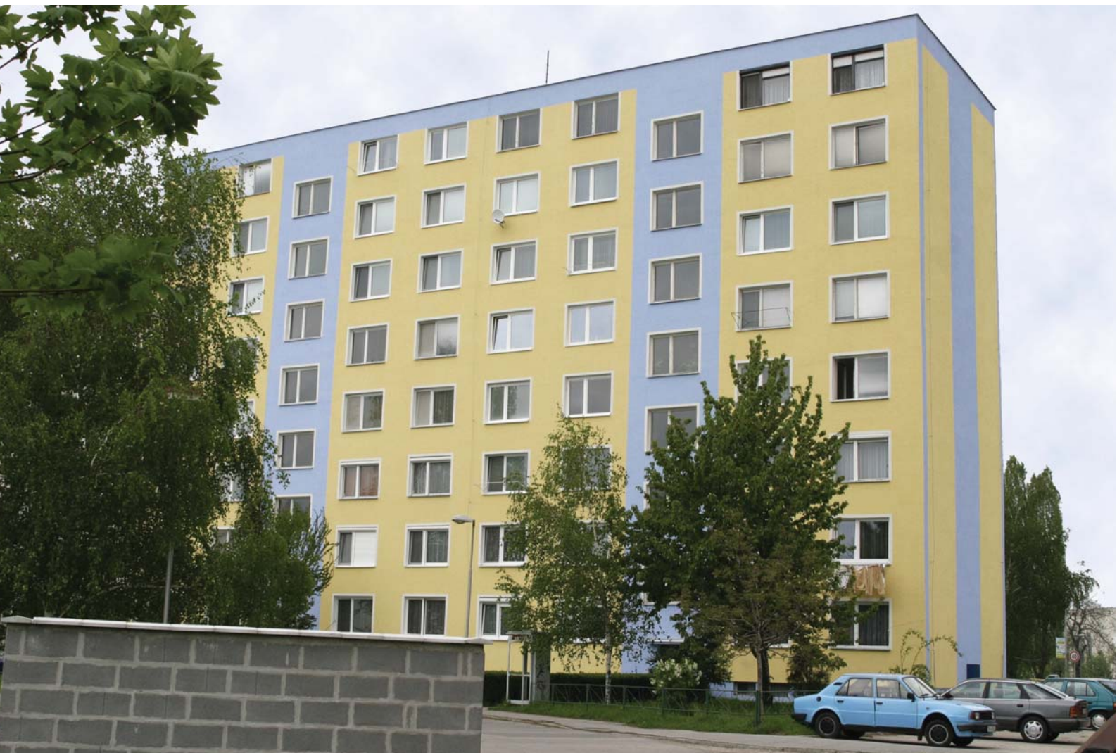
Šaľa, rekonštrukcia a obnova bytových domov Šaľa, Rekonstruktion und Reparatur von Wohnhäusern
